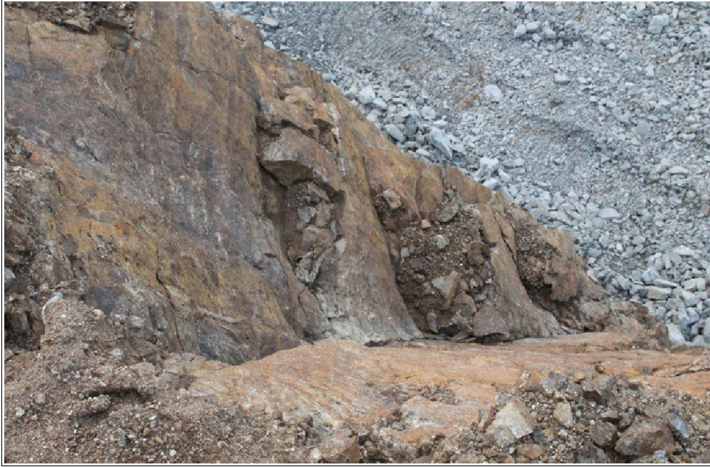
【그림 23】 B 영역 상세사진 (썰기파괴 양상)
