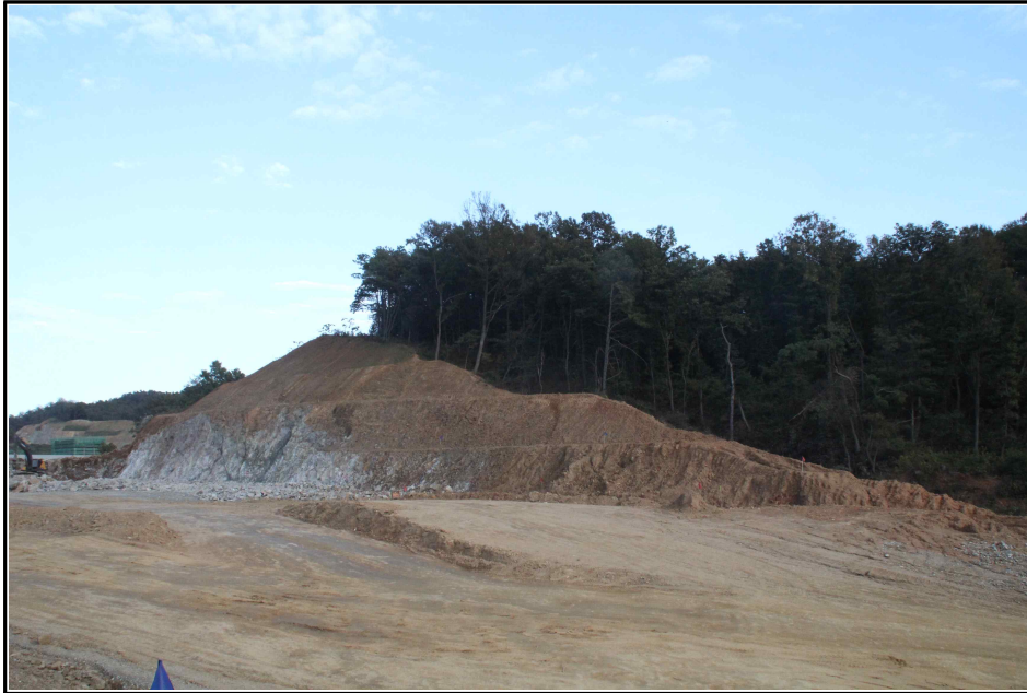
【그림 3】 깎기비탈면 시점부 측면 사진
