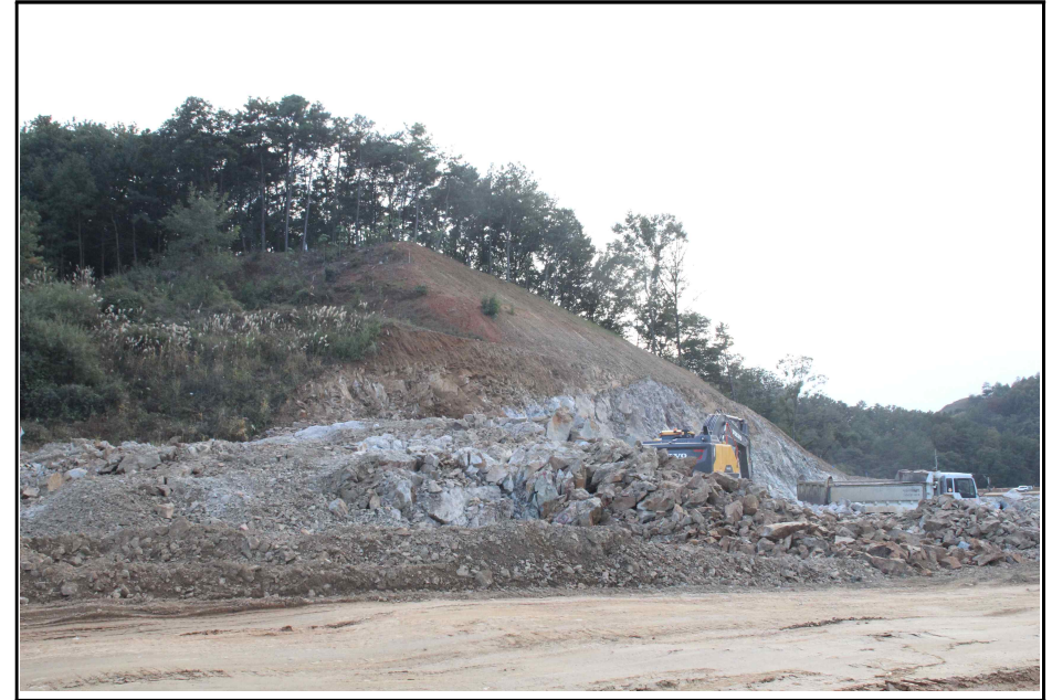
【그림 4】 깎기비탈면 종점부 측면 사진
