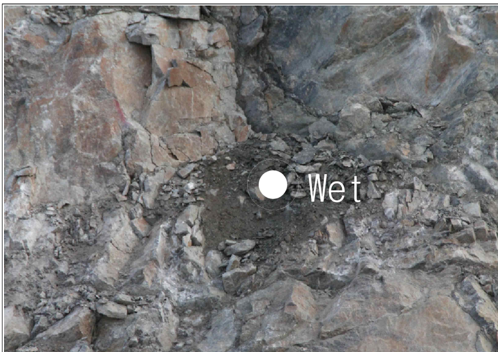
【그림 22】 B 영역 상세사진 (지하수 유출)
