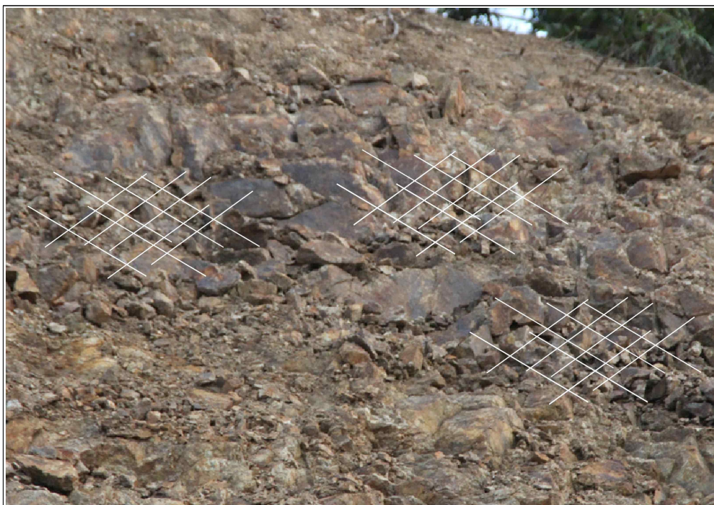
【그림 29】 C 영역 상세사진 (세편화된 암석)
