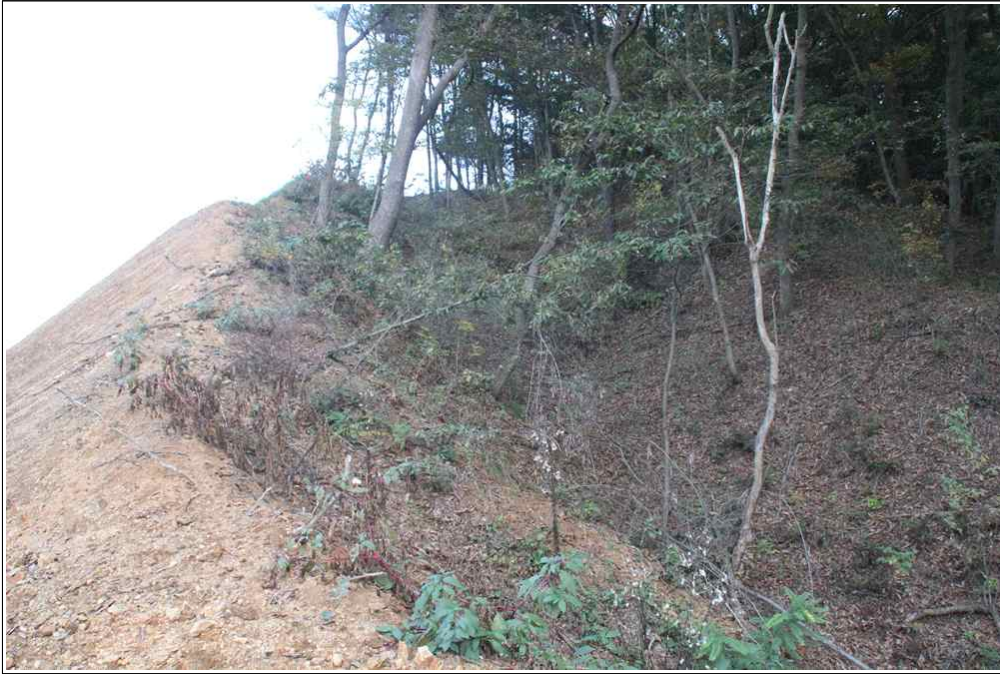
【그림 5】 상부자연비탈면 (수목의 기울어짐 및 포행)
